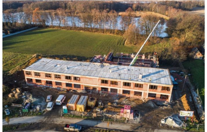
Nowo budowana szkoła w Porębie Wielkiej będzie służyć uczniom od września 2018 roku. Fot. Marcin Karetka
